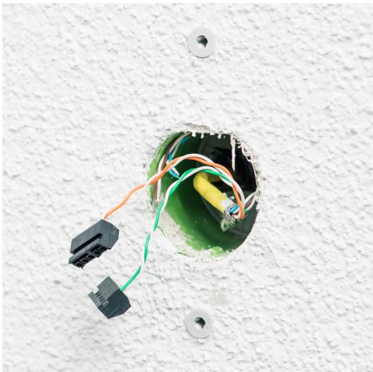
**2. Standard Unterputzdose mit Stromdrähten und a/b Leitung an die Klemmen angeschlossen**
