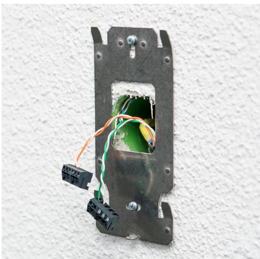
**3. Montageblech auf die Standard Unterputzdose an der Wand montieren**
